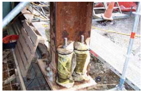
(d) Rocking column detail
