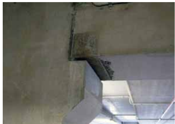
(d) Steel armoured beam-column joint
