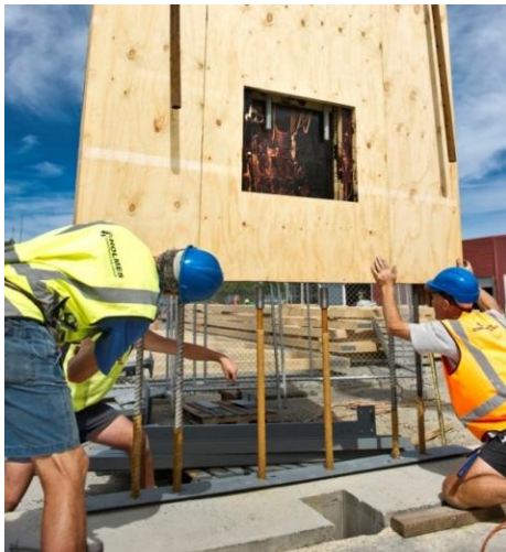
(d) Erecting wall panel.
