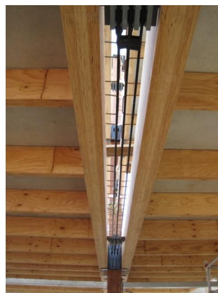
(d) Draped tendons between beams.
