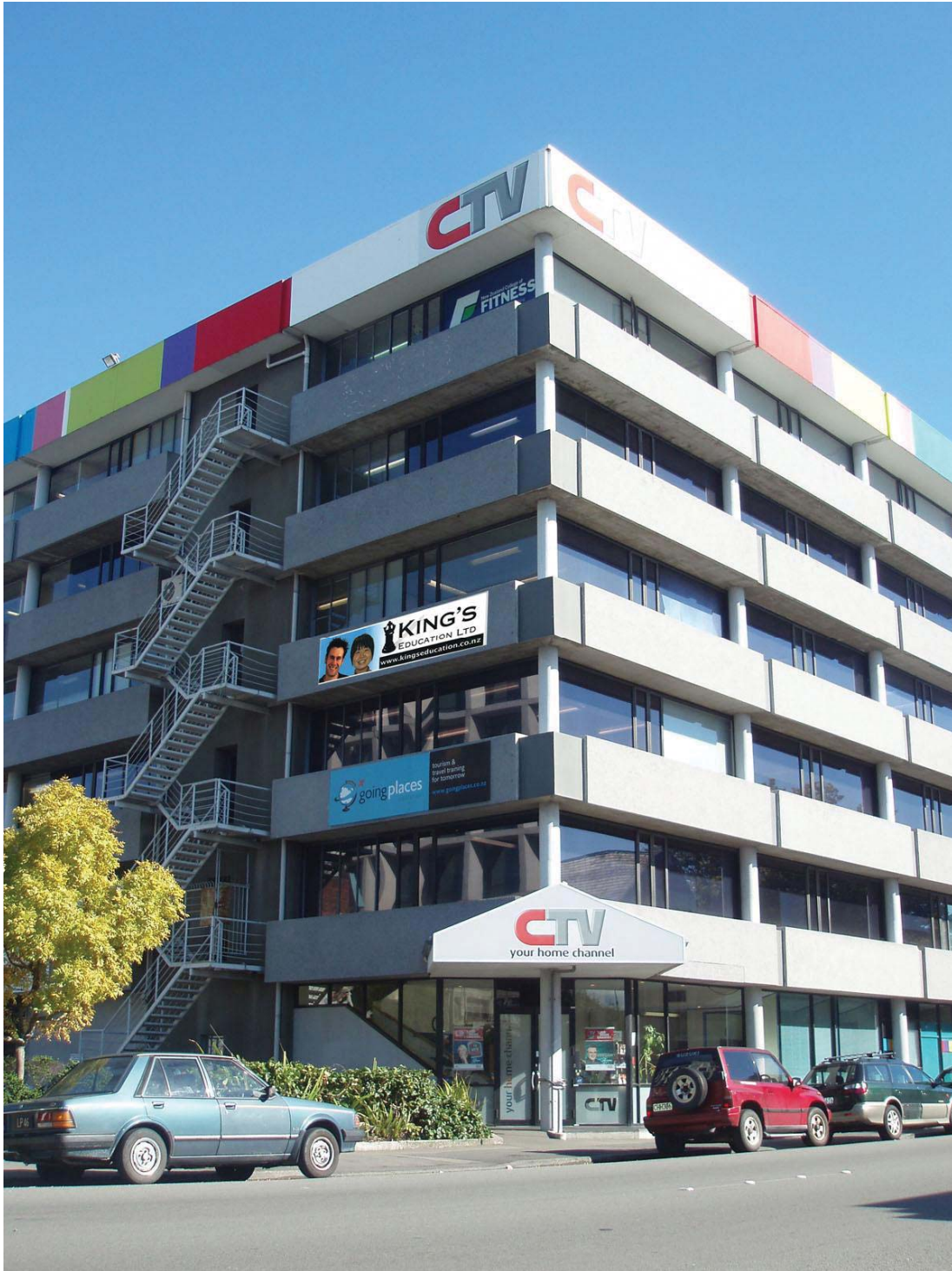
건물의 동남쪽 전경
