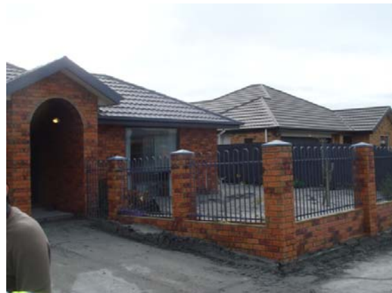
(d) Damage due to liquefaction
