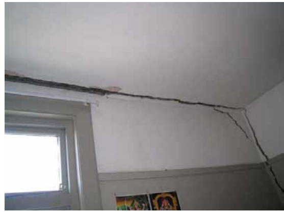
(d) Internal view showing wall separation
