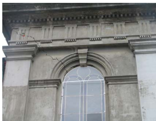
(d) Diagonal crack extending from window opening
