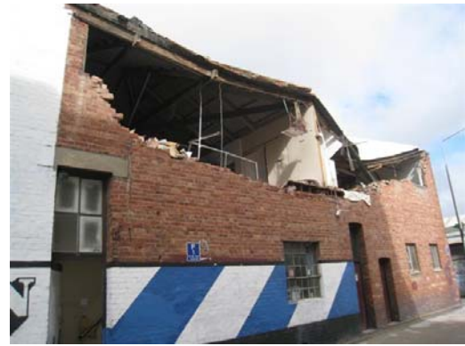
(d) Failure of long wall
